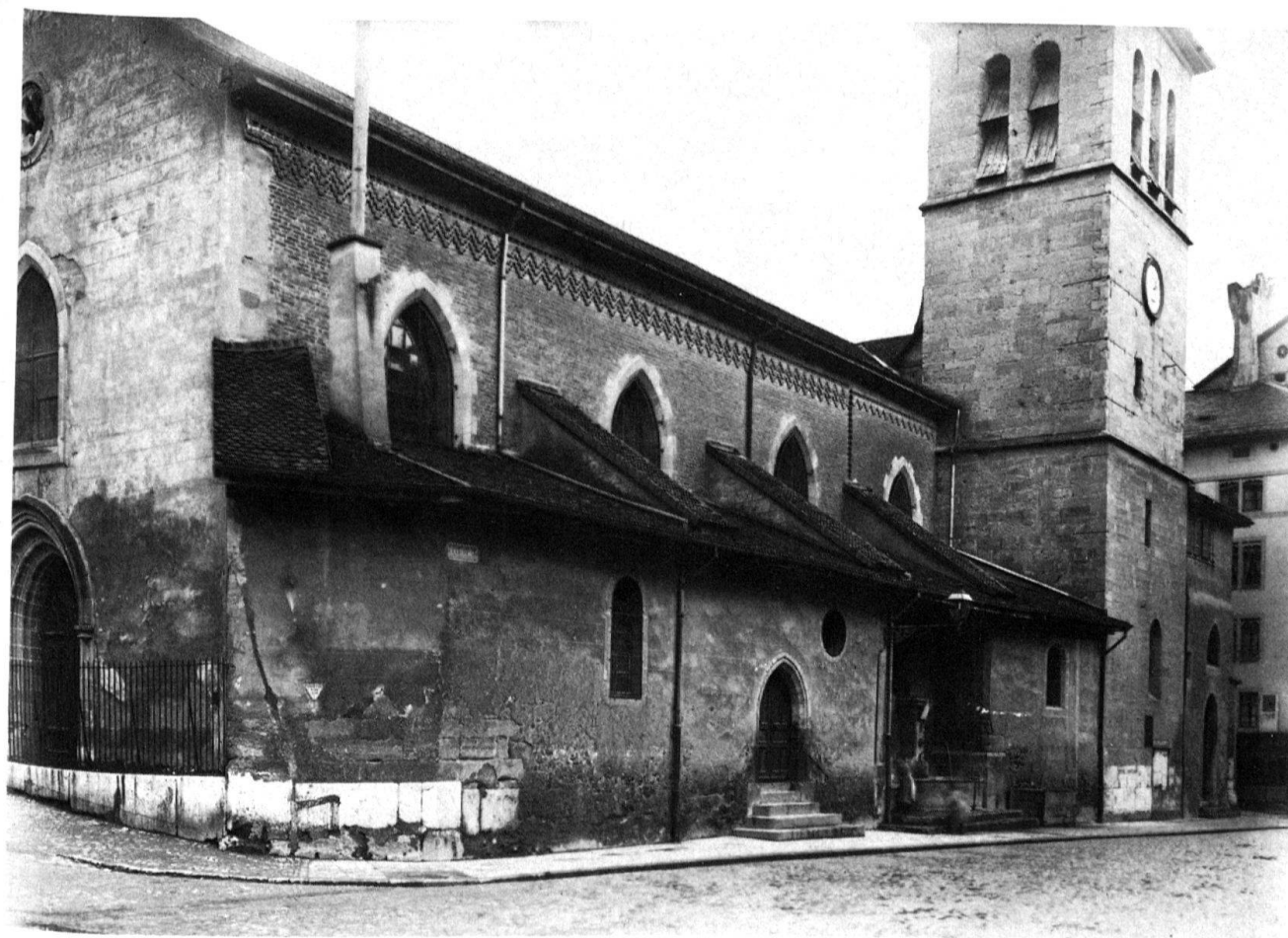
1 L'église Saint-Gervais à Genève. La façade sud avant la restauration.
