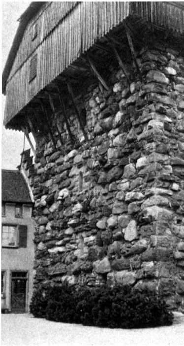
1 Mammertshofen (Roggwil TG). Teilweise bewohnter Wehrturm mit Megalith- bzw. Findlingsmauerwerk.
