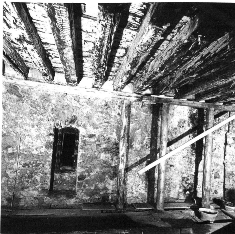
4 Limmatquai 76, «Glentnerturm». Unregelmässig dicht sind die mittelalterlichen Geschossbalken direkt ins Mauerwerk verlegt.
