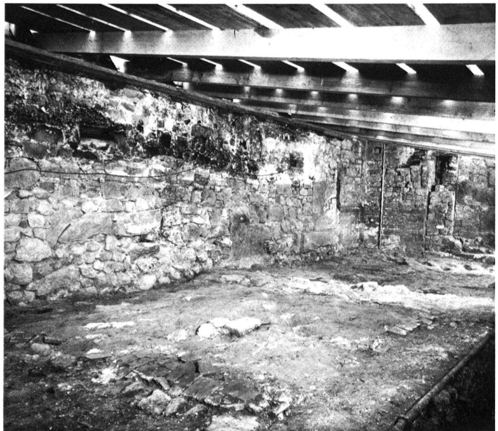
4 St. Petersinsel, ehem. Cluniazenserpriorat. Blick durch die Vierung in den südlichen Querschiffarm der Klosterkirche.
