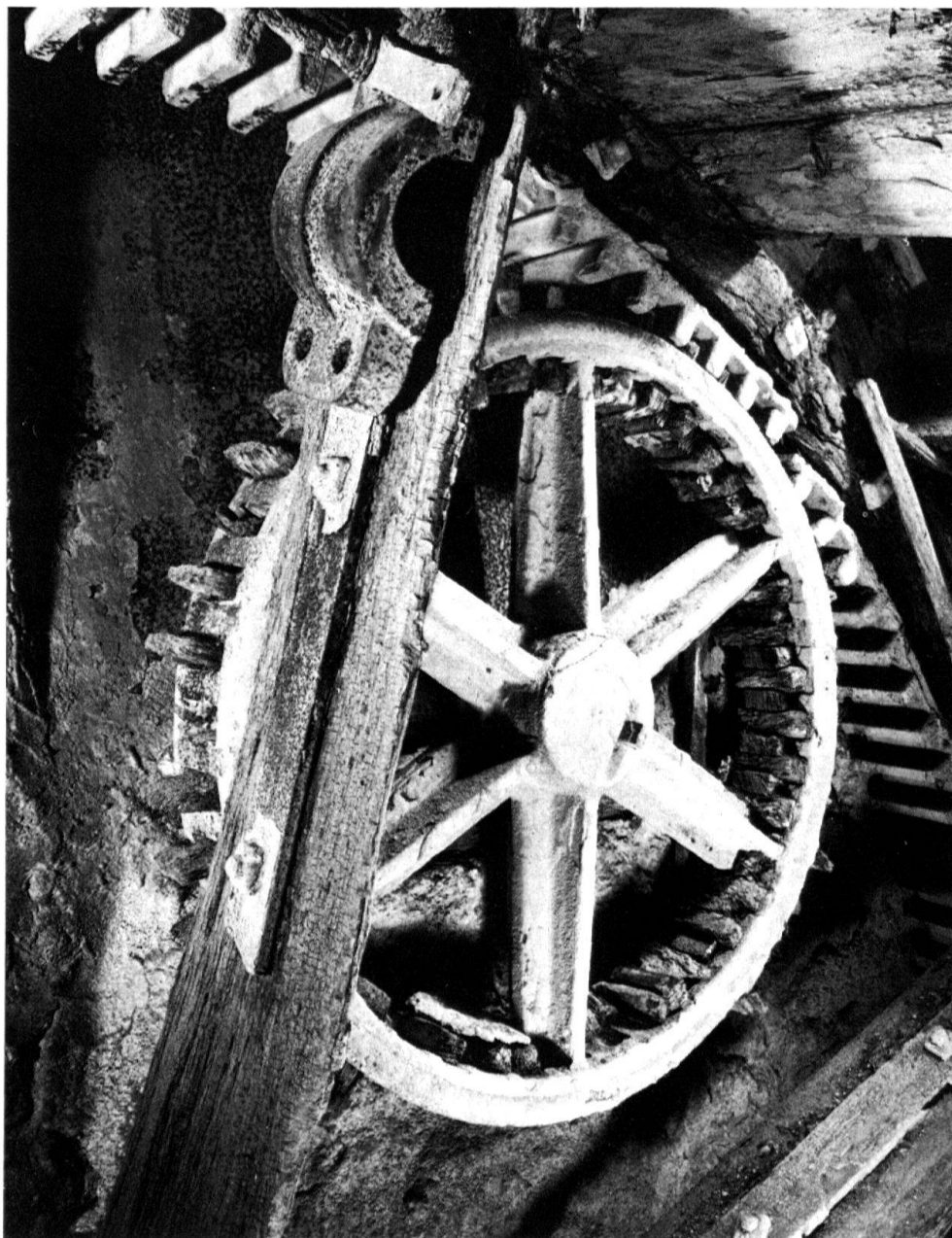
1 L'eau canalisée se jetait sur une roue à auges de 490 cm de diamètre, ceinturée d'un coffre de 70 cm de large. Un ruban de 160 dents métalliques, composé de huit segments, court sous le support résineux, soutenu par une charpente en chêne. Ces dents entraînent un pignon interne d'un mètre de diamètre, aux 42 dents en bois, enchâssées.
