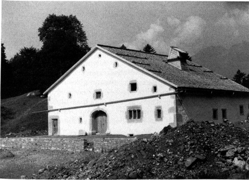
4 La ferme de la Recorne restaurée, état des travaux en septembre 1984.
