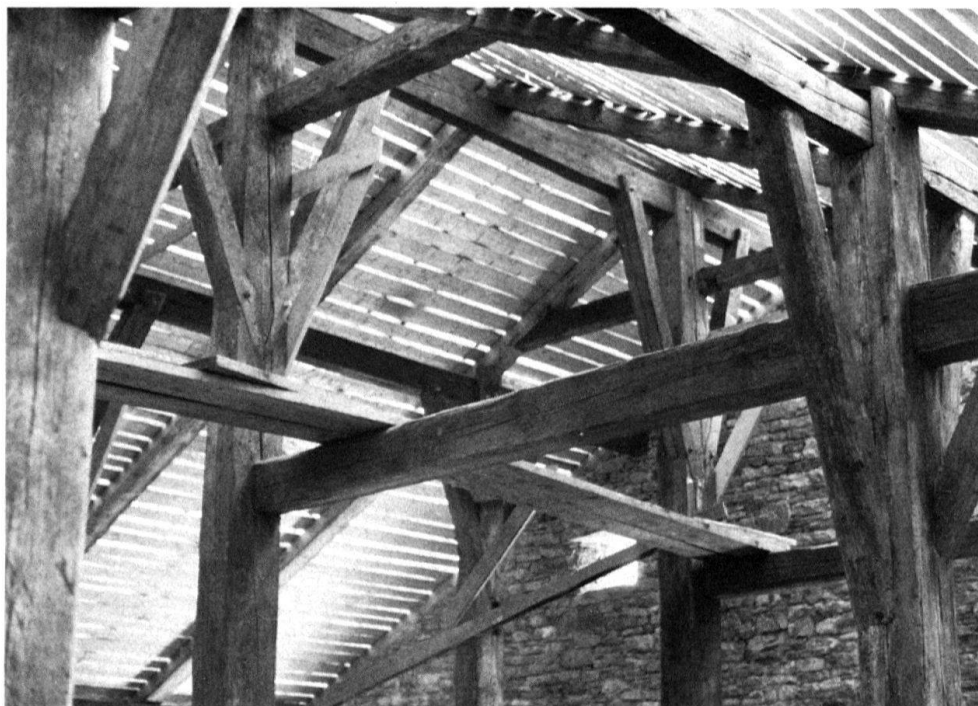
2 La charpente remon- tée à Ballenberg, avec le lattage destiné à sup- porter les bardeaux.
