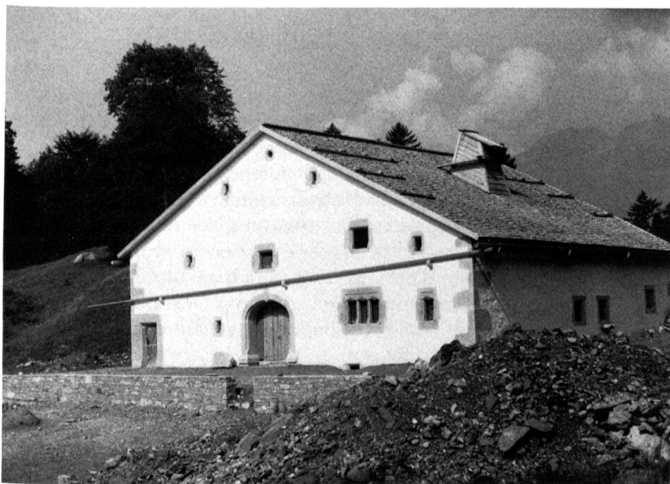
4 La ferme de la Recorne restaurée, état des travaux en septembre 1984.
