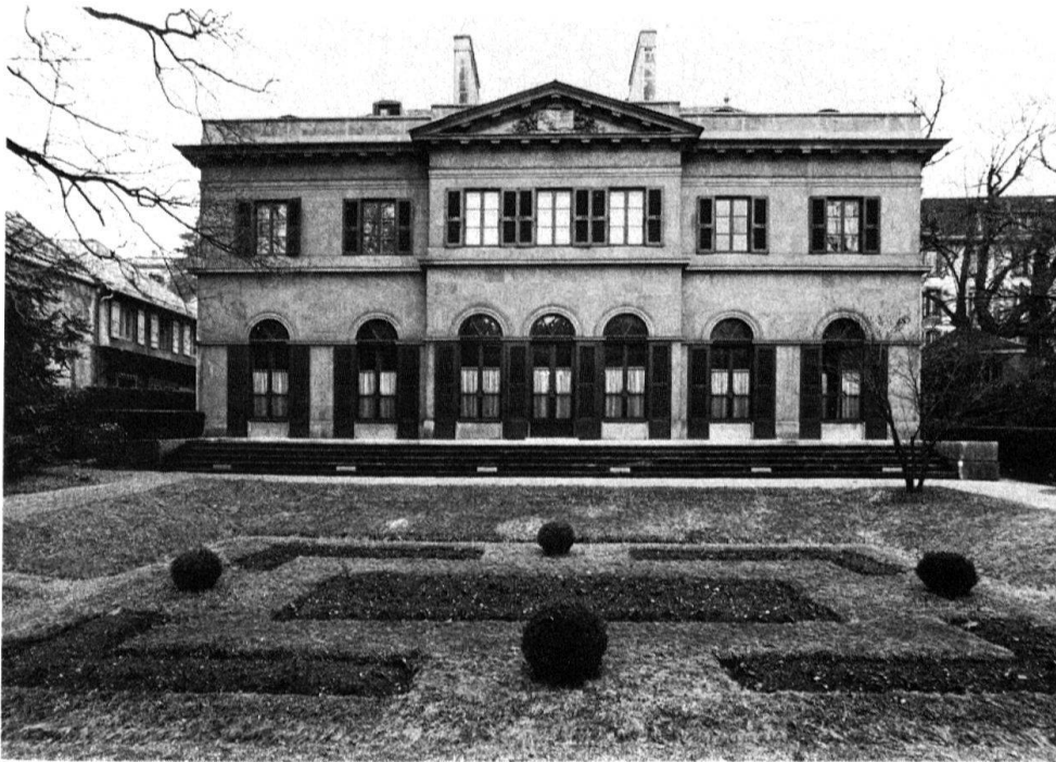
2 Das Stadtpalais à la mode: Haus Pourtalès-Castellane am Faubourg de l'Hôpital 21, 1814 nach Plänen von Anton Fröhlicher für den in preussischen und französischen Diensten stehenden Offizier Frédéric de Pourtalès-Castellane erbaut. Von der Strasse abgesetzter «Würfel» auf dem Präsentierteller des einsichtigen Gartens.
