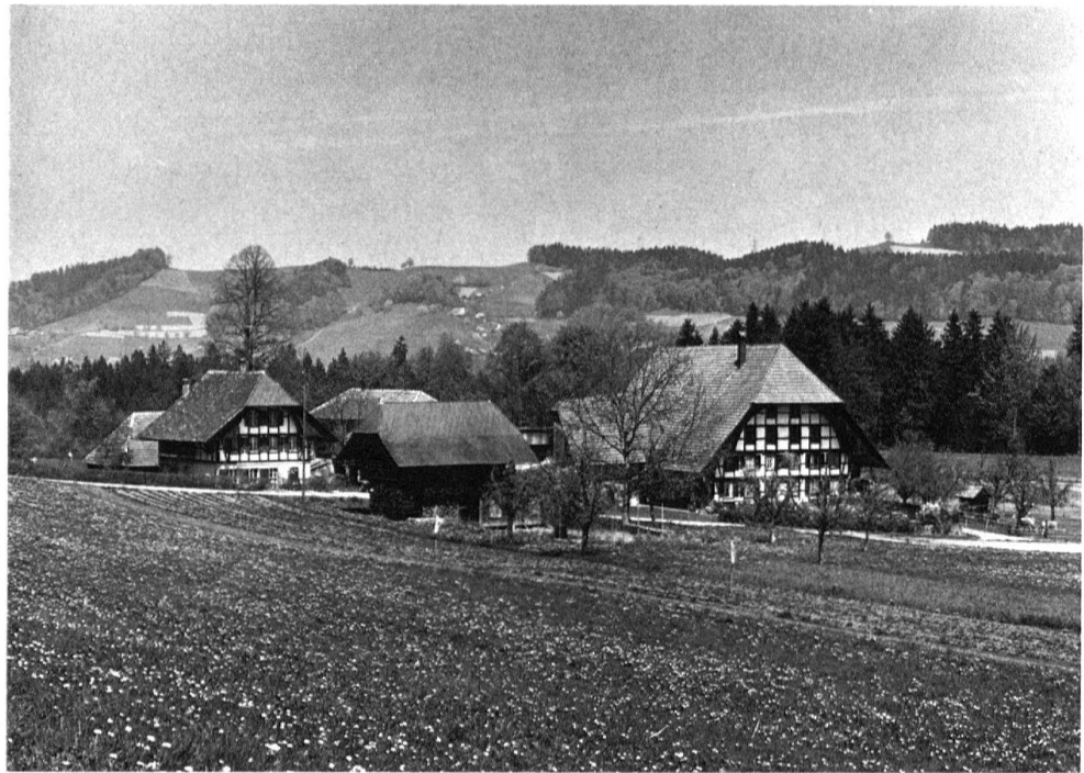
5 Rüderswil BE, Toggelbrunnen. Ferme intacte d'un paysan-propriétaire dans l'Emmental; groupement de bâtiments de fonctions différentes.
