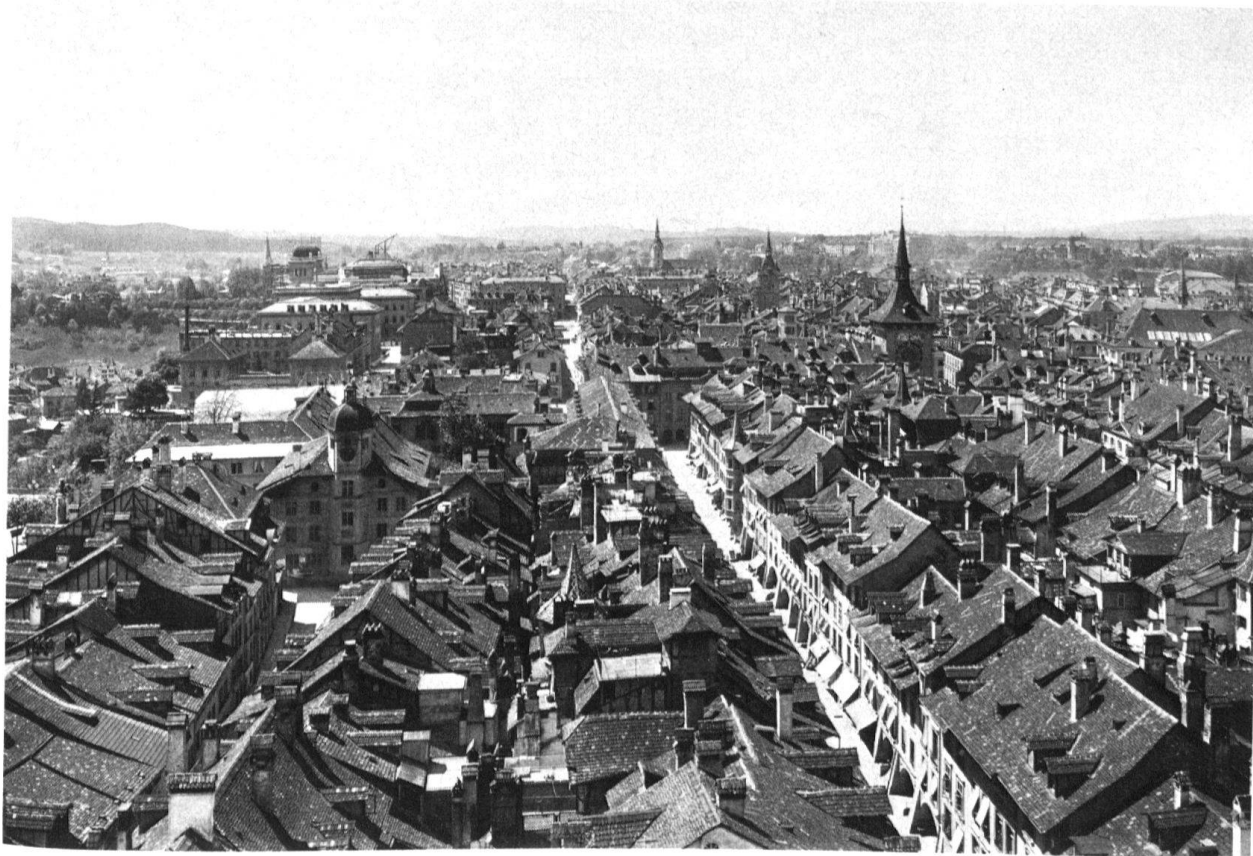
2 Berna, vista generale da est. Fotografia prima del 1906.
