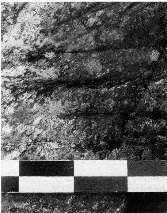
Abb. 1. Ober Gurtellen UR. Umgehungsweg der Reuss-Schluchten zwischen Wiler und Amsteg. Die Trittrillen, die das Ausgleiten von Fuss und Huf verhindern sollen, sind von der Begehung während Jahrhunderten fast wieder ausgelöscht (Koord. 691 37/178 24. Massstab mit 10-cm-Teilung)
