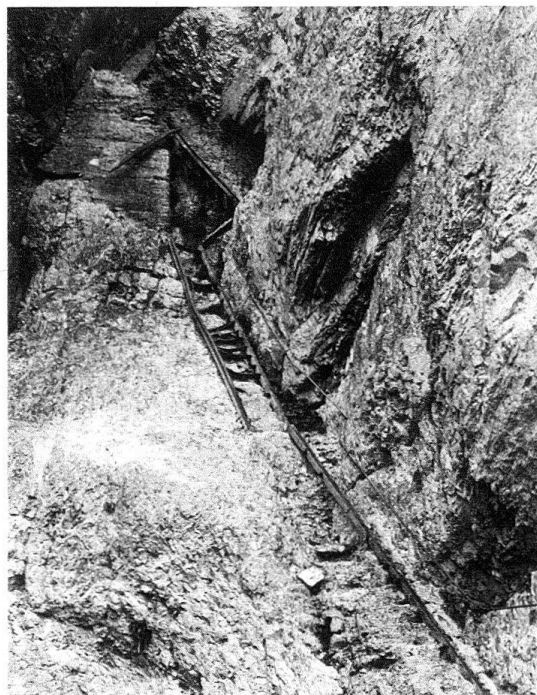
Abb. 2. Flims-Fidaz GR. Der Leiteraufstieg zu den Pinutwiesen wird bereits im 18. Jahrhundert erwähnt. Die jetzige Stahlkonstruktion ist zu grossen Teilen von Steinschlag zerstört, seit sie nicht mehr unterhalten wird
