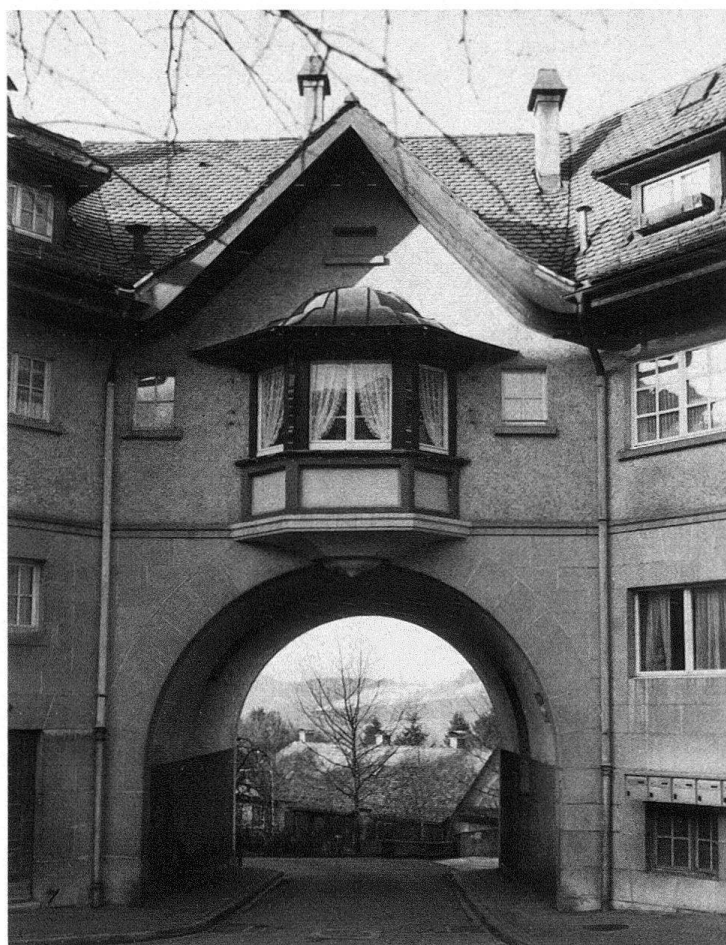
Abb. 6. St. Gallen, Schorensiedlung. Torbogen am ehemaligen Geschäftshaus
