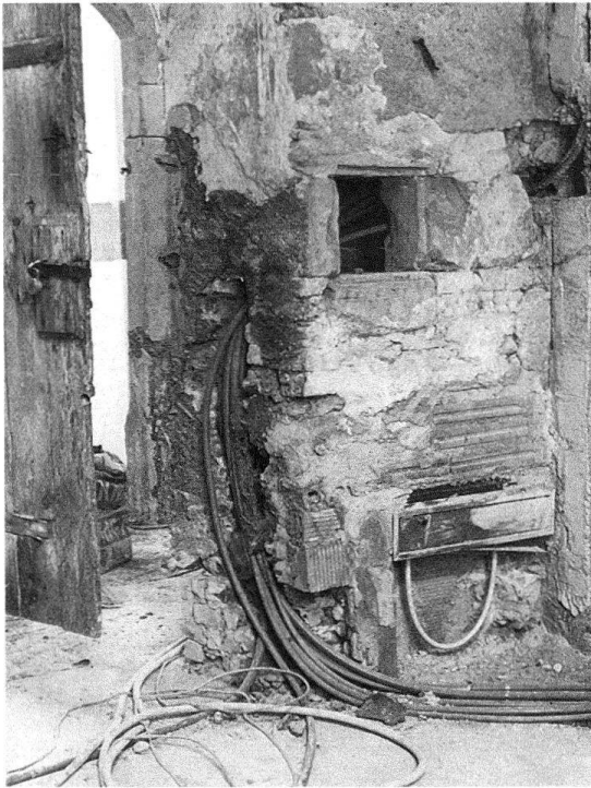
Abb. 3. Leitungen unter Putz zu legen, ist immer mit Zerstörung von Bausubstanz verbunden. Wie lange können wir uns diesen Perfektionismus noch leisten?
