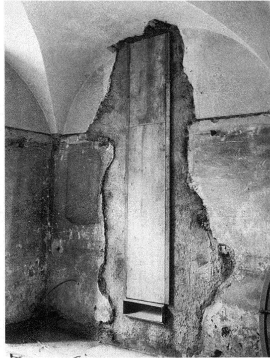
Abb. 3. Leitungen unter Putz zu legen, ist immer mit Zerstörung von Bausubstanz verbunden. Wie lange können wir uns diesen Perfektionismus noch leisten?
