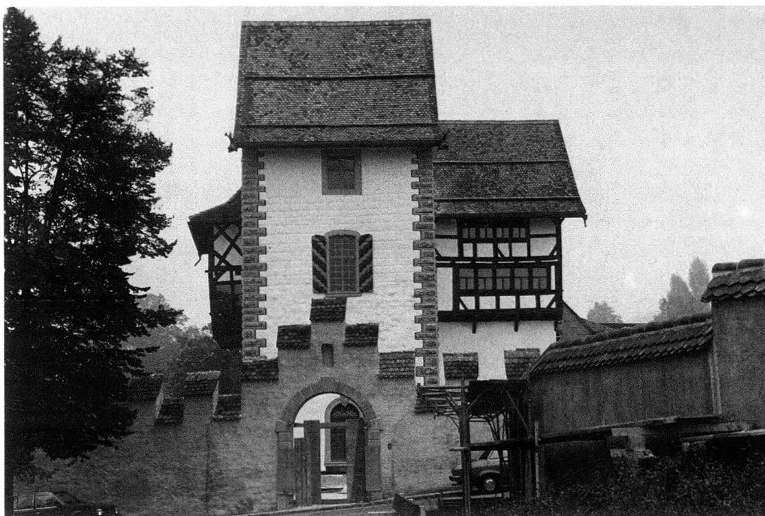
Abb. 1. Zug, die restaurierte Burg von Süden, kurz vor Abschluss der Arbeiten. Am Turm zeigen die horizontalen Mauerfugen die Höhe des kyburgischen Mauerwerks an. Giebel, Eckquaderbemalung und Fachwerkbau zweite Hälfte des 16. Jahrhunderts
