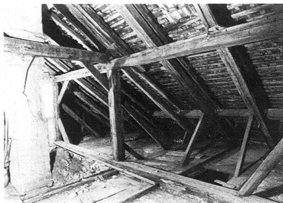
Abb. 4/5. Zug, Burg. Estrichraum vor und nach der Restaurierung. Isolierung des Daches oberhalb der alten, aufgedoppelten Sparren, möglichst weitgehende Erhaltung des alten Materials
