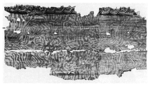
Abb. 7. Twann, Haus Nr. 136, erstes Obergeschoss, Hauptstube, Rähmbalken Stube/Gang des spätgotischen Deckensystems, abgelöstes und gereinigtes Fladerpapier-Tapetenfragment, wohl Mitte 16. Jh. Der eingedruckte Querstrich am Rand gibt den Übergang von der geraden Balkenfront zur Profilierung an. Der Wellenband-Fries schloss die Masertapete gegen die Bretterdecke ab
