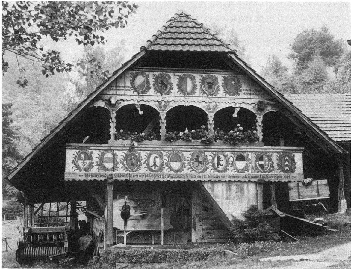
Abb. 1. Wynigen, Speicher Schärer, erbaut Mitte 18. Jh. Mit Kantonswappen bemalt um 1810 und 1978 letztmals erneuert
