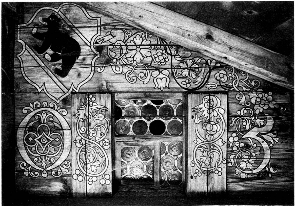
Abb. 9 und 10. Boltigen, Weissenbach, Haus Seewer. Rechtes Giebfeld vor und nach der Restaurierung
