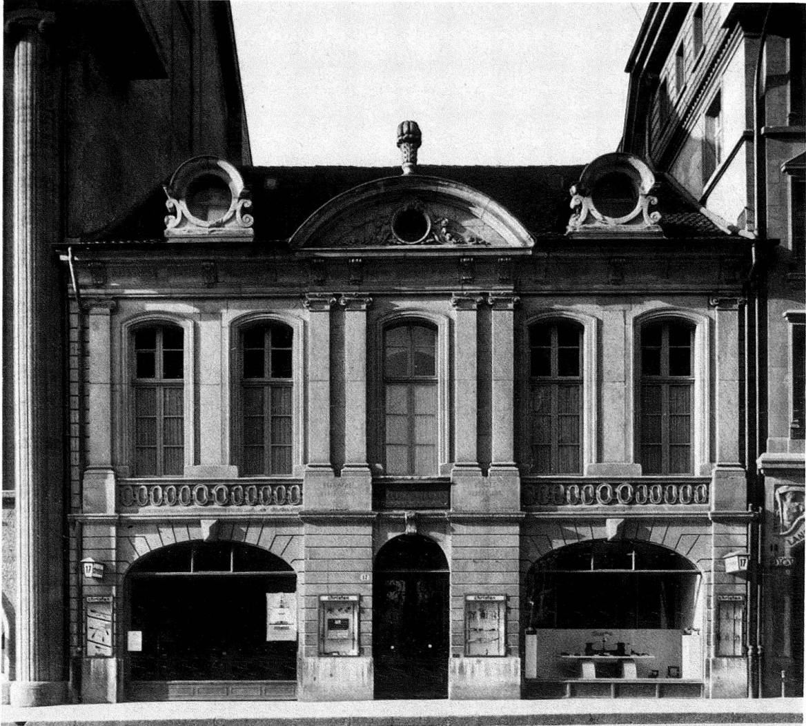
Abb. 2. Bern, Rathaus des Äusseren Standes. Die Fassade an der Zeughausgasse vor der Restaurierung
