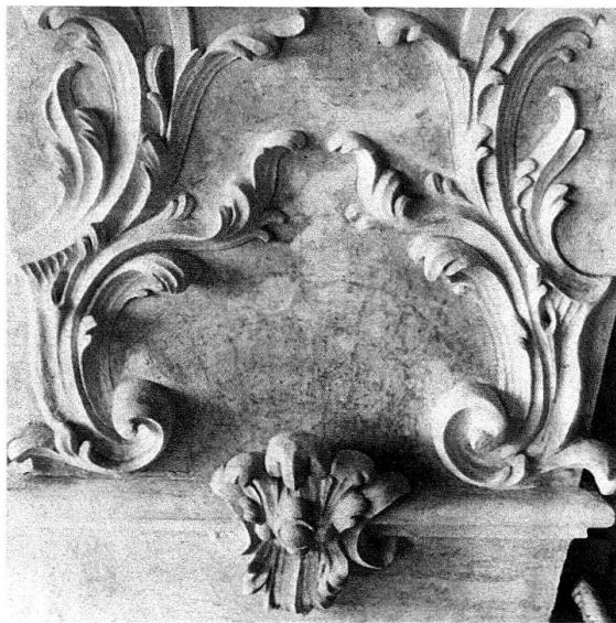
Abb. 10. Kloster Einsiedeln, Chor. Freigelegter Wandstuck vor der Neufassung
