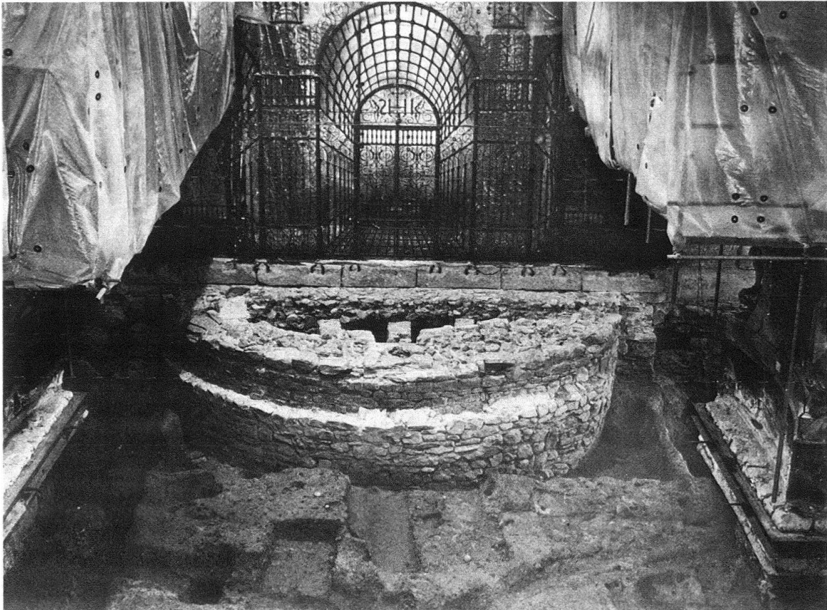
Abb. 2. Kloster Einsiedeln, Chor. Blick nach Westen gegen das Chorgitter. Romanisches Krypten-Halbrund mit stark vortretendem oberem Vorfundament
