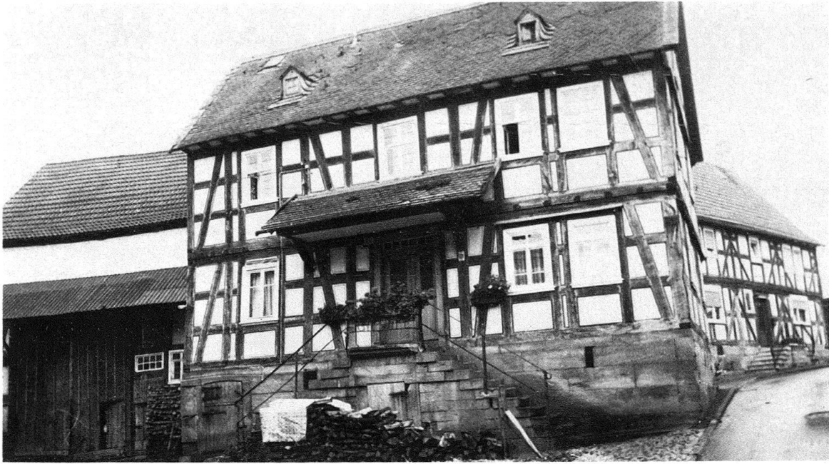
Ebsdorf. Ländliches Fachwerkhaus von 1857 auf hohem Sockel (Keller) mit Freitreppe als barock-«herrschaftliches» Architekturzeichen. Ebenfalls dreizonig: Erdgeschoss mit 2 Stuben und mittlerem Ern, Obergeschoss mit Kammern. Der Stall links befindet sich im Sockelteil
