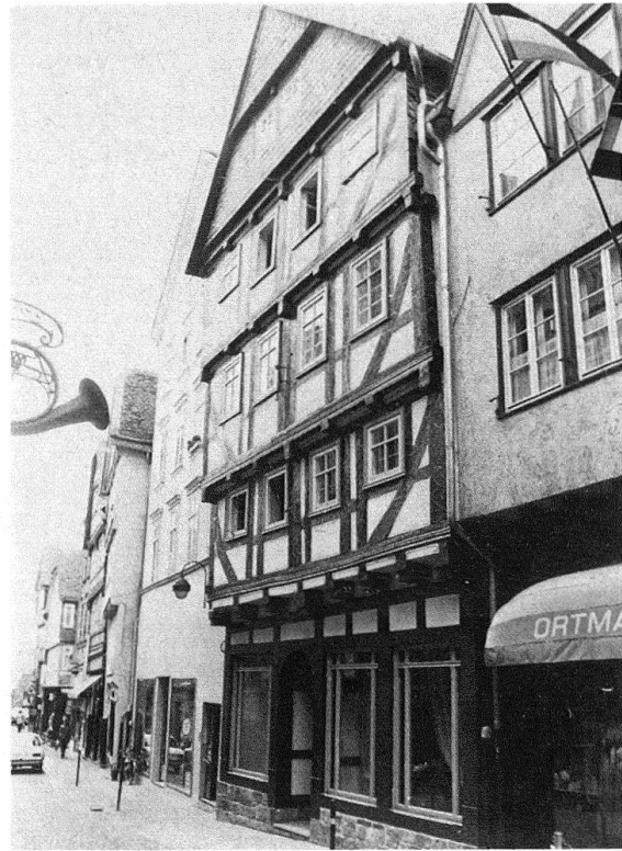
Marburg, Barfüsserstrasse 27. Städtisches Fachwerkhause um 1600 mit vorkragenden Stockwerken. Während und nach der Sanierung, wobei die barocke Marmorierung der Balken von etwa 1700 erhalten werden konnte
