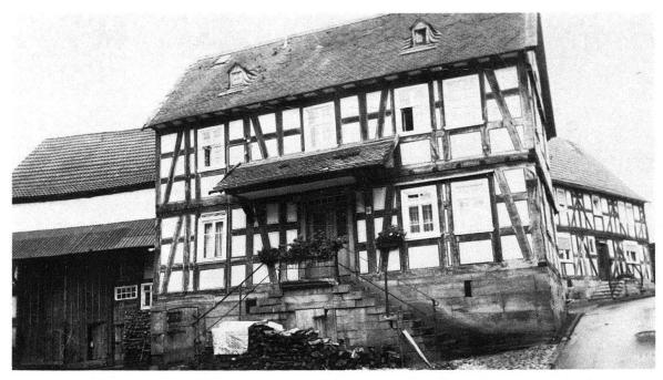
Ebsdorf. Ländliches Fachwerkhaus von 1857 auf hohem Sockel (Keller) mit Freitreppe als barock-«herrschaftliches» Architekturzeichen. Ebenfalls dreizonig: Erdgeschoss mit 2 Stuben und mittlerem Ern, Obergeschoss mit Kammern. Der Stall links befindet sich im Sockelteil
