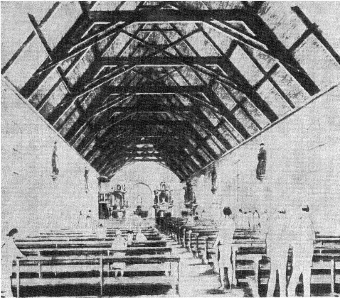
Amden, Pfarrkirche. Perspektive mit geöffnetem Dachstuhl des Spätbarocks. Projekt von P. Scherrer 1980
