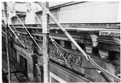
Zürich. Hauptbahnhof. Vorrichtung zur Reinigung der Fassaden nur mit Wasser
