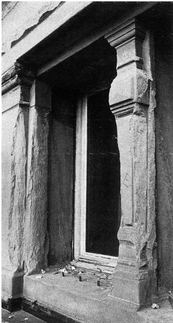
Zürich. Rämistrasse 23, «Gewerbebank». Fensterpfeiler im verwitterten Zustand und nach erfolgter Aufmodellierung
