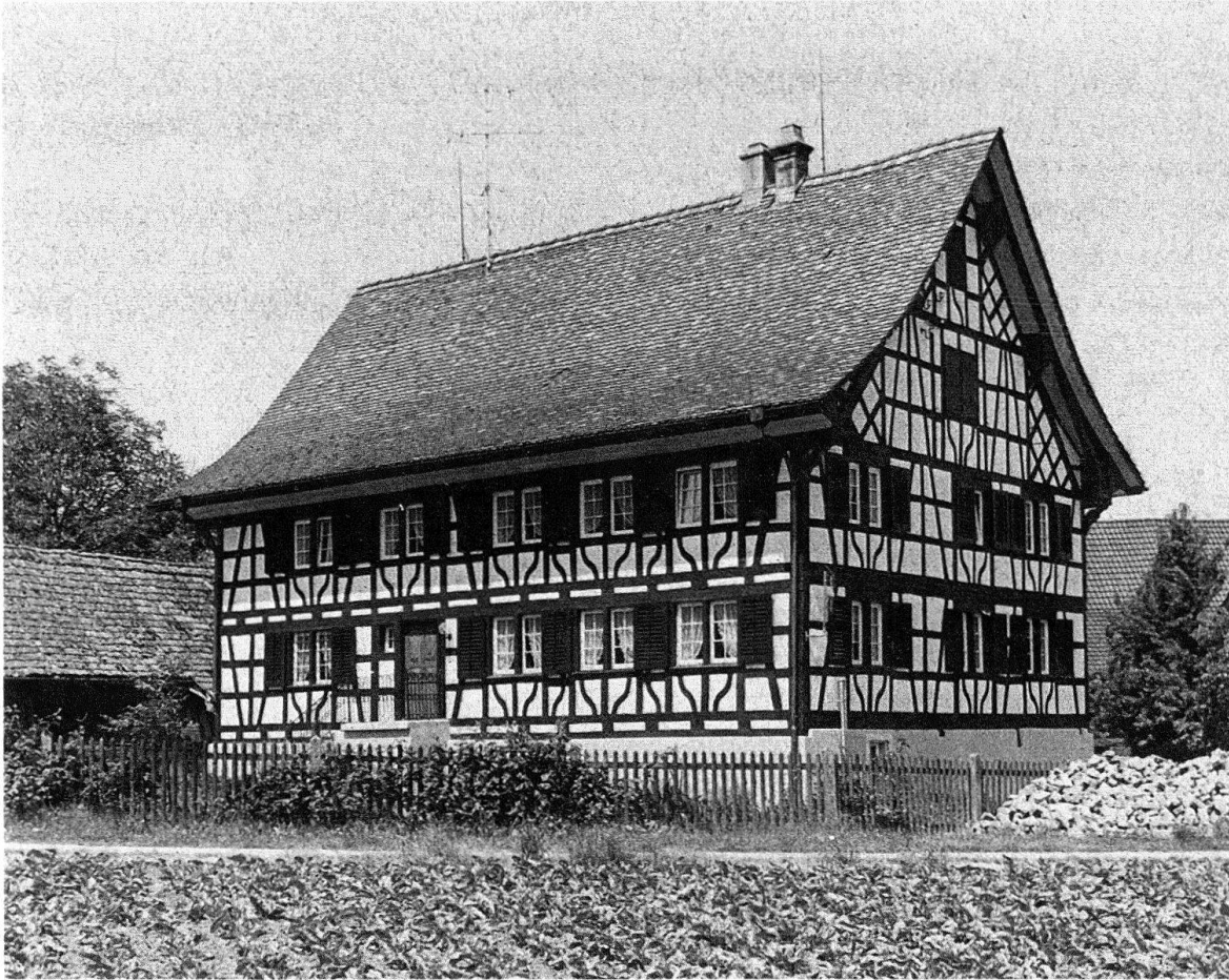
Waltalingen. Rietmühle, zweite Hälfte 18. Jh. Nach der Restaurierung 1979/80
