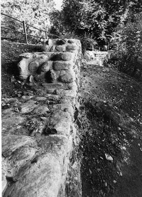
Uetliberg. Uto-Kulm. Die 1980 entdeckte Umfassungsmauer der Uetliburg
