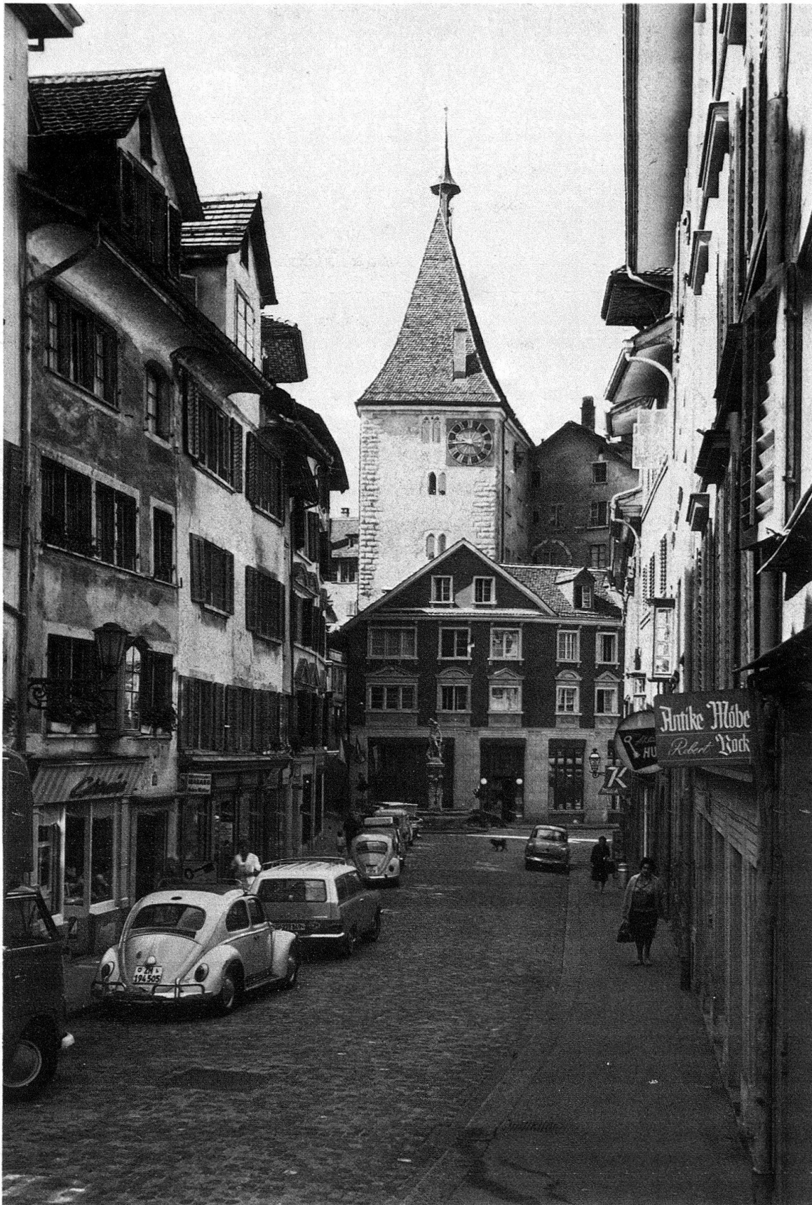
Abb. 3. Zürich. Neumarkt mit Grimmenturm (13. Jh.). Typische Stadterweiterungszone des 12./13. Jh.
