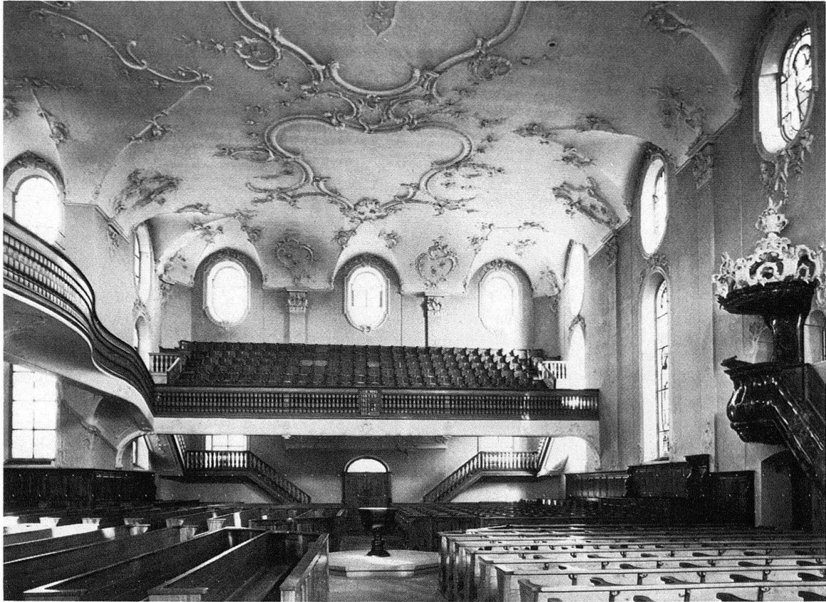
Wädenswil. Reformierte Kirche, 1764–1767 durch Hans Ulrich Grubenmann erbaut
