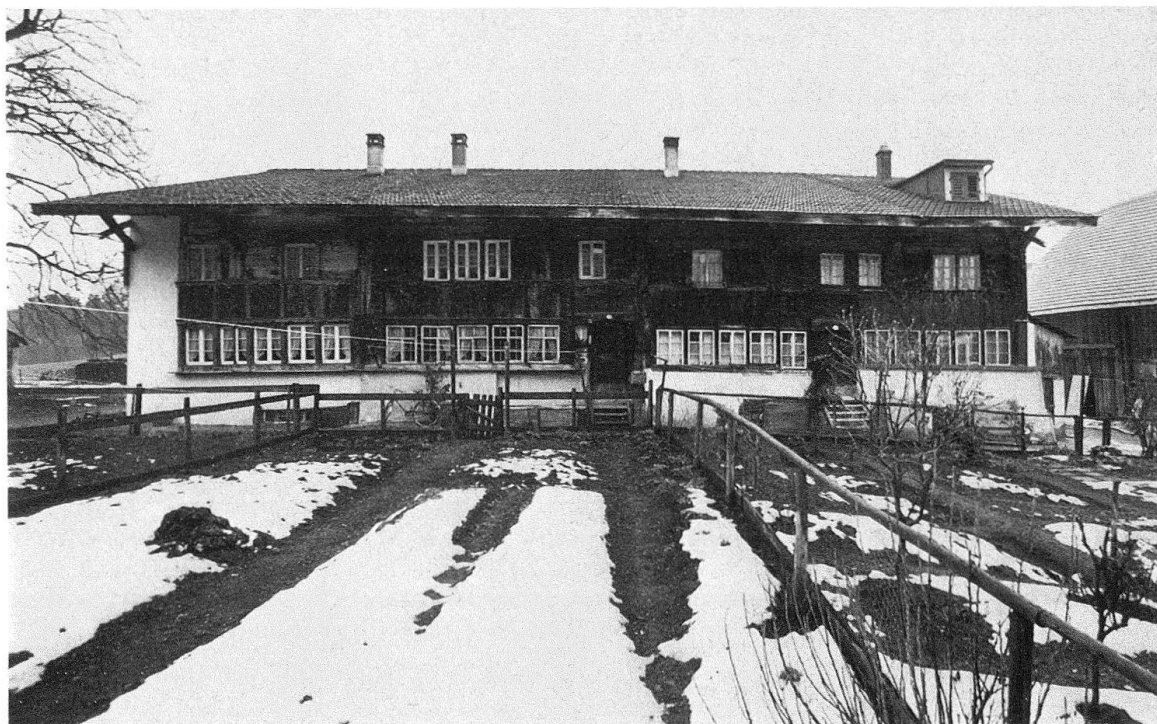
Rutschberg-Pfäffikon. Bockhornhaus. Prototyp eines Zürcher Oberländer Flarzhauses aus dem 16. Jh. Barocke Fassadengestaltung von 1785
