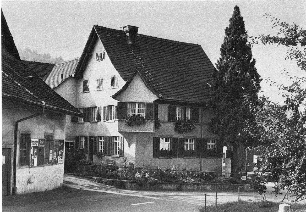
Gräslikon/Berg am Irchel. Bauernhaus. 1911 von den Architekten Kündig und Oetiker in Anlehnung an lokale Bautraditionen erstellt
