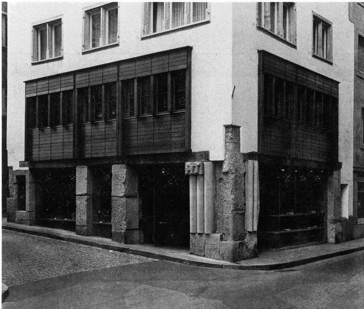
Zürich, Haus zur Gelben Gilde. Umbau von Manuel Pauli, 1969
