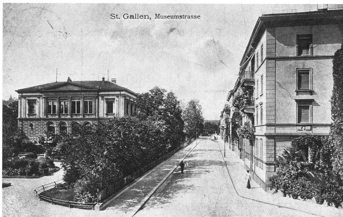
Abb. 13. Museum – Parklandschaft – Quartier: Kunklers Museumsbau am Rande des St. Galler Stadtparkes war Ausgangspunkt für die gesamte, nördlich anschliessende Quartierentwicklung (heute Museumsquartier). Die Fassaden der Wohngebäude an der Museumstrasse wiederholen das rhythmische Vor- und Zurück-treten der Längsseiten des Museums. Ansicht gegen Westen (Zentralbibliothek Zürich)
