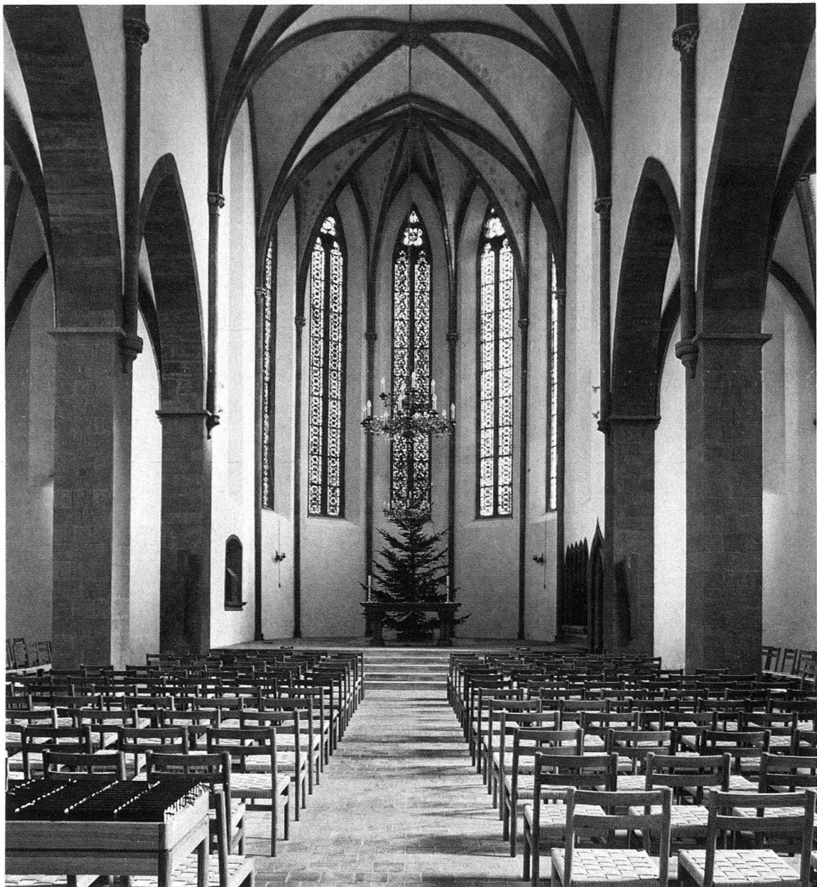
Basel. Predigerkirche. Das Altarhaus mit den abgedeckten Gewölbemalereien (zur Weihnachtszeit) nach der Restaurierung
