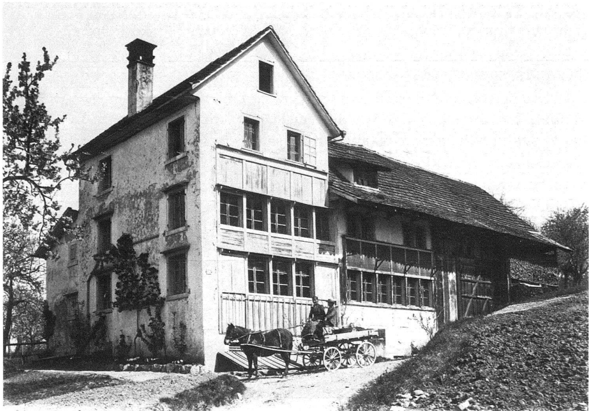
Abb. 1. Zürich-Hirslanden. Burenweg 35/37. Zustand um 1895. Ein wahrscheinlich aus dem 17. Jh. stammendes Bauernhaus ist im 19. Jh. durch einen höheren Anbau erweitert worden. Man beachte die gleiche Schiebladenart wie am Altbau
