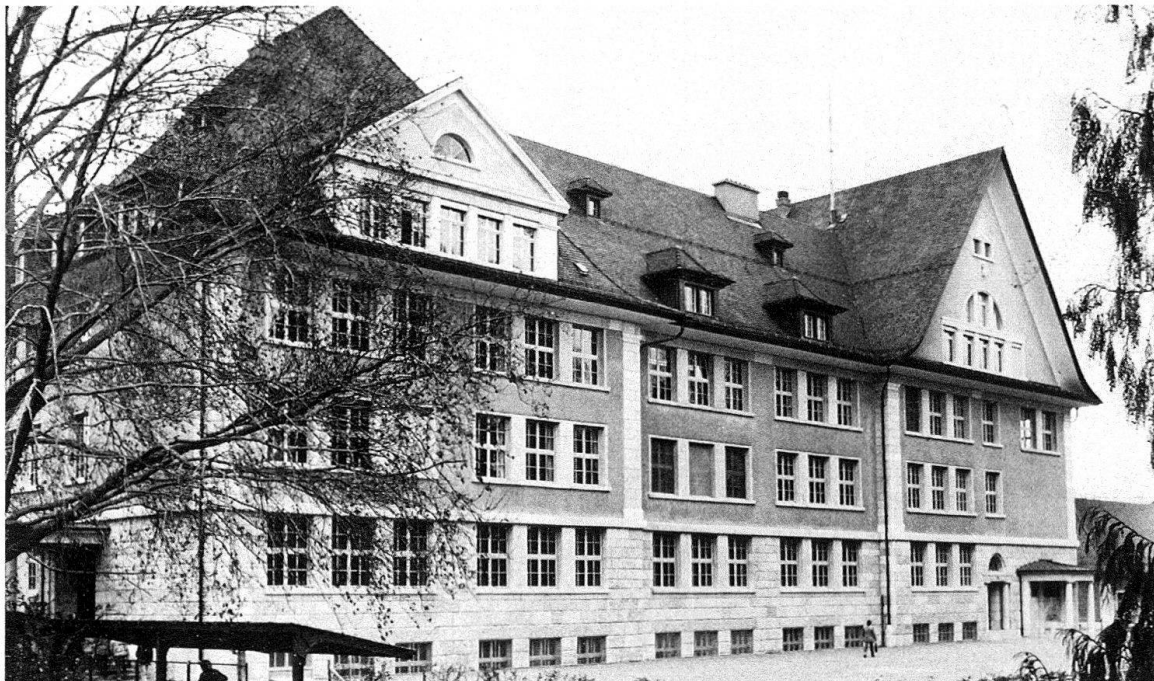
Winterthur. Schulhaus «Heiligberg», erbaut 1909–1912 von den Architekten Bridler + Völki, 1976–1978 innen und aussen vollständig renoviert
