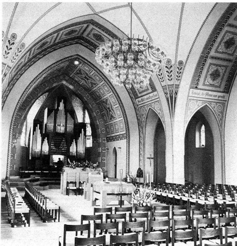
Töss. Katholische Kirche St. Joseph. 1913/14 erbaut von Adolf Gaudy, 1977 restauriert
