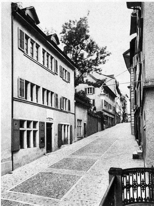
Zürich. Kirchgasse. Die neue Kleinplästerung, ohne Trottoirs – ausgeführt nach Plänen der städtischen Denkmalpflege: ein wohnlicher Bereich, ideal für den Fussgänger
