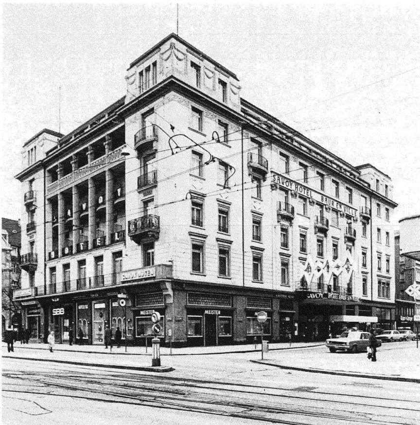
Zürich. Savoy Hotel Baur en Ville, Zustand im Dezember 1974. Das Erdgeschoss ist stark verändert, dem Dachgesims fehlt der Zahnschnittfries
