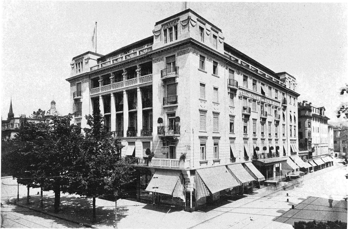
Zürich. Poststrasse 12, Savoy Hotel Baur en Ville nach dem durchgreifenden Umbau 1907/08 von Pflughard & Haefeli.
