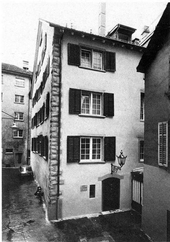
Zürich. Laternengasse 4, «Zum Höfli». Rekonstruktion der Eckquadermalerei. – Detail der Eckquadermalerei: Links Original, rechts Rekonstruktion
