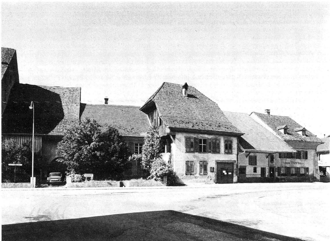
Von rechts nach links: Restaurant Bären mit Scheune. – Ormalingenstrasse 3 mit hohem Krüppelwalmdach, Ende 18. Jahrhundert. – Ormalingenstrasse 1 mit niederem Wohnteil und höherer Scheune, datiert 1797. Verschwunden wären eigentlich 3 Baukuben von der Scheune links bis zum hohen Krüppelwalmdach rechts. Dadurch wäre eine kaum wieder zu schliessende Lücke im Dorfbild entstanden
