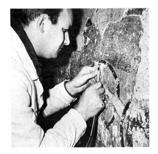
Freilegung von Wandmalerei: Oskar Emmenegger am Wellenmotor mit aufgesetztem Handstück zwecks Abschleifen späterer Schichten
