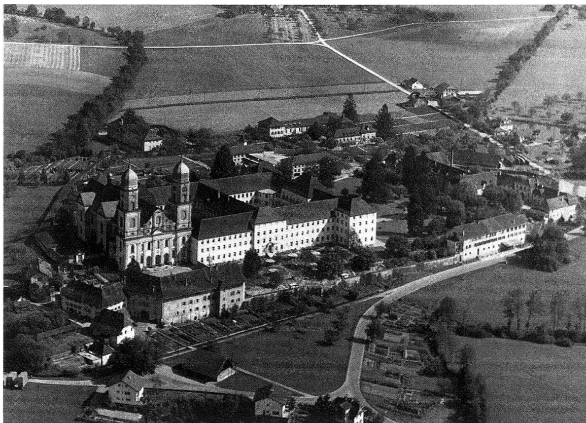
St. Urban. Flugansicht der Gesamtanlage von Westen. Die Kirche 1711–1717 von Franz Beer
