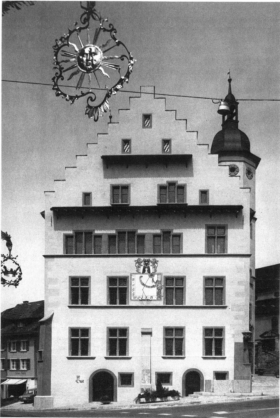
Sursee. Rathaus, die Südostfassade nach der Gesamtrestaurierung 1972/75. Erbaut 1539–1545
