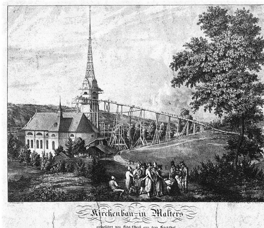
Malters. Kirchenbau von 1833–1835 mit eindrucklicher Gerüstbrücke für den Turmbau (seltene Darstellung). Zeichnung von J. Schwegler, Lithographie von den Gebr. Eglin in Luzern. Bildersammlung und Foto SLB
