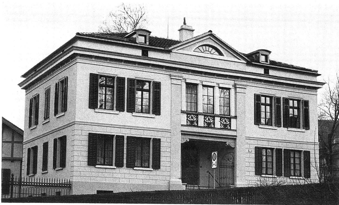
Zürich. Haus «Zum Ehrenberg», Rämistrasse 26, 1837 als klassizistische Villa von Carl Ferdinand von Ehrenberg erbaut, heute Lyceumclub. Oben: Hauptfassade gegen das Kunsthaus vor, unten: nach der Restaurierung
