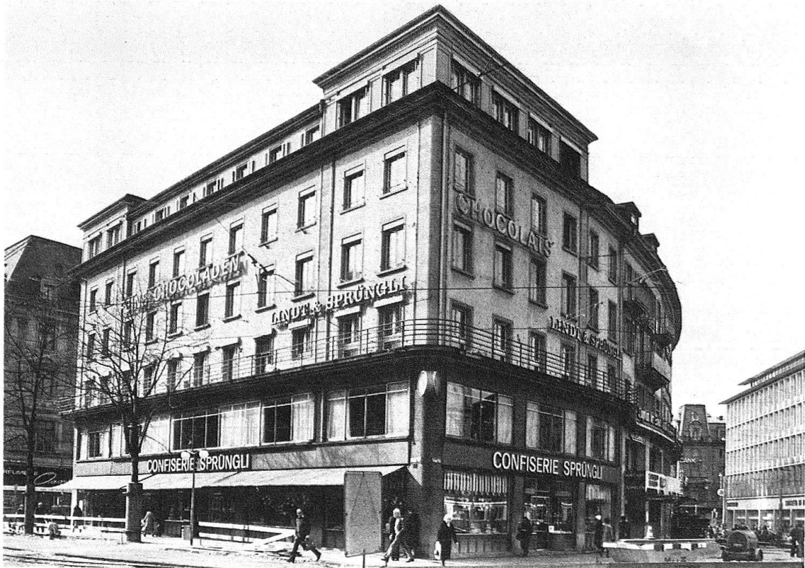
Zürich. «Sprüngli-Haus», Bahnhofstrasse 21 (am Paradeplatz), 1859 erbaut, in der Ladenfront immer wieder verändert. Oben: Fassadengestaltung 1930/31, unten: Zustand Januar 1978 nach der Restaurierung 1976/77
