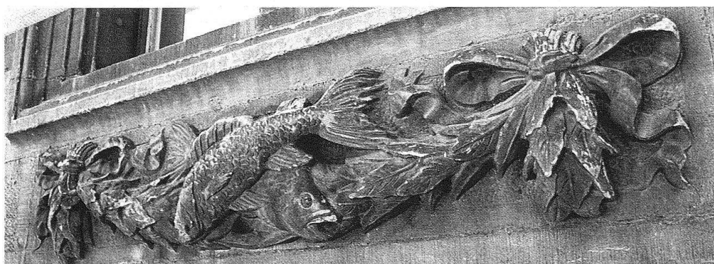
Zürich, Rathaus. Fischornament. Zustand 1974 vor der Versetzung ins Innere des Hauses
