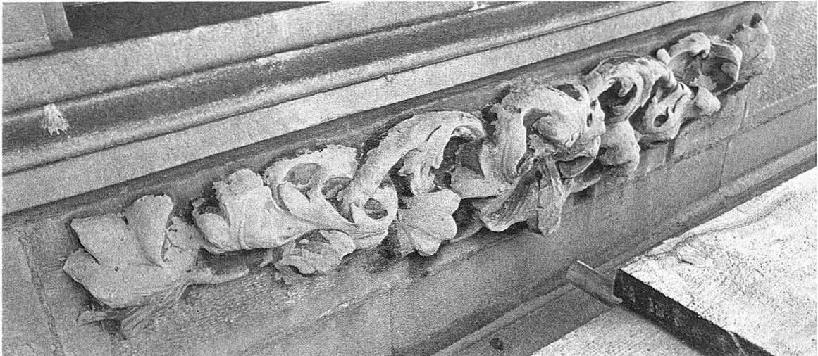
Vor der Restaurierung von 1974–1976
