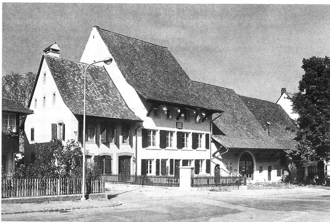
Itingen. Die Häuser Nr. 33 und Nr. 35 nach der Restaurierung. Die in der Scheune eingebaute Wohnung ist vor allem auf die Rückseite orientiert, so dass an der Scheune ausser der Belichtung durch das Scheunentor nichts verändert werden musste
