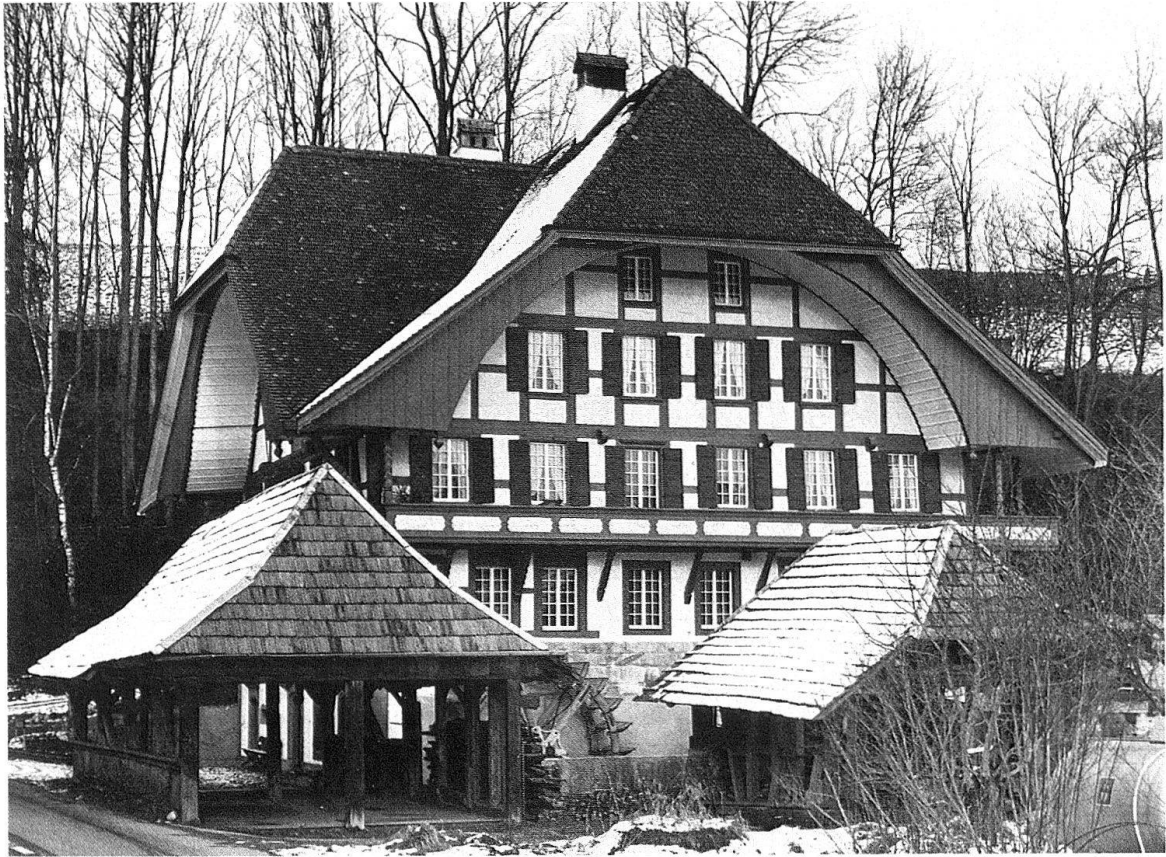
Lützelflüh, Kulturmühle, erb. 1821. Südfassade nach der Restaurierung 1977. Im Vordergrund Wagenschopf (als Holzbrücke über den Mühlebach) und ehem. Stampfhaus
