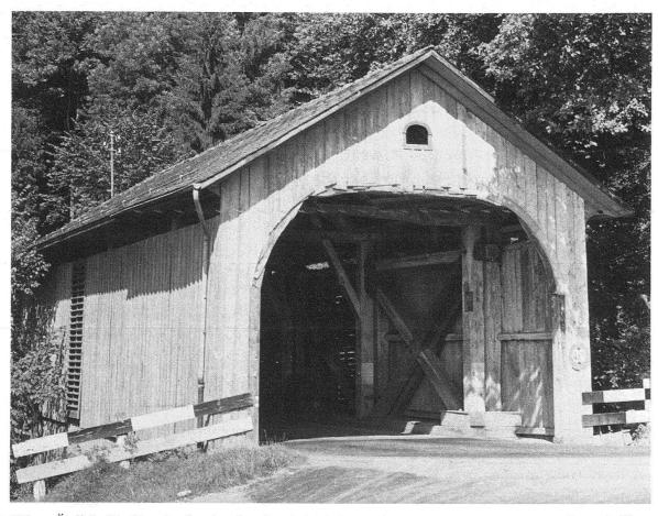
Abb. 3. Ostliche Einfahrt der Brücke über den Aabach bei Eschenbach SG, 1830 erbaut von Franz Spiller
