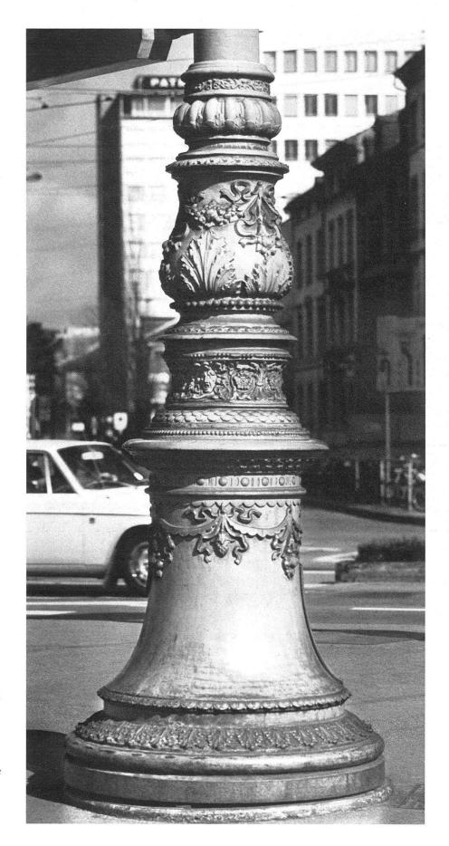
Leitungsmast am Aeschenplatz, aufgestellt vermutlich beim Bau der Birsfelder Linie im Jahre 1897. Gusseisenverkleidung aus dem Eisenwerk Klus bei Balsthal, dieselbe wie an den Masten der 1895 eröffneten ersten elektrischen Tramlinie der Stadt
