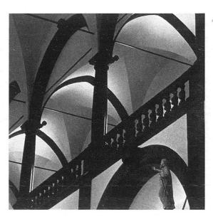
2. Moudon VD, église St-Etienne Versenkte Direkt- und Indirektbeleuchtung in den Triforien. Spots und Tiefstrahler als Zusatzbeleuchtung im Chor. Eine minimale Beleuchtungsstärke wurde akzeptiert.
