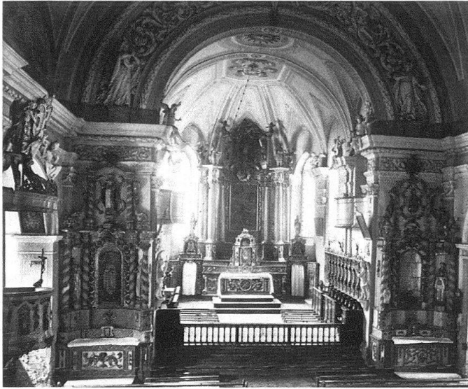
Disentis GR. Kath. Pfarrkirche St. Johann. Zustand um 1920 (links oben), Zustand 1966 (rechts oben), Zustand 1976 nach Abschluss der Restaurierung (unten), anlässlich welcher u.a. die Stukkaturen von 1930 weitgehend abgeschlagen und im Chor durch eine Rekonstruktion der Dekoration von etwa 1670/1680 ersetzt worden sind
