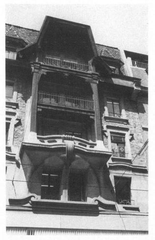
Fig. 3. Balcon bulbeux en béton et «dôme» en charpente, rue du Marché («Pharmacie principale»), 1903/1904
