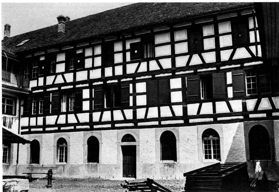
MAGDENAU SG. Zisterzienserkloster. Die den Innenhof (Kreuzgang) umstehenden Gebäude sind grossenteils Riegelbauten. Unsere Bilder zeigen die Südseite des Innenhofes vor der Restaurierung mit dem verputzten Riegelwerk und die Nordseite nach der Restaurierung mit dem freigelegten und instandgesetzten Riegelwerk. Photos: Eidgenössisches Archiv für Denkmalpflege, Zürich
