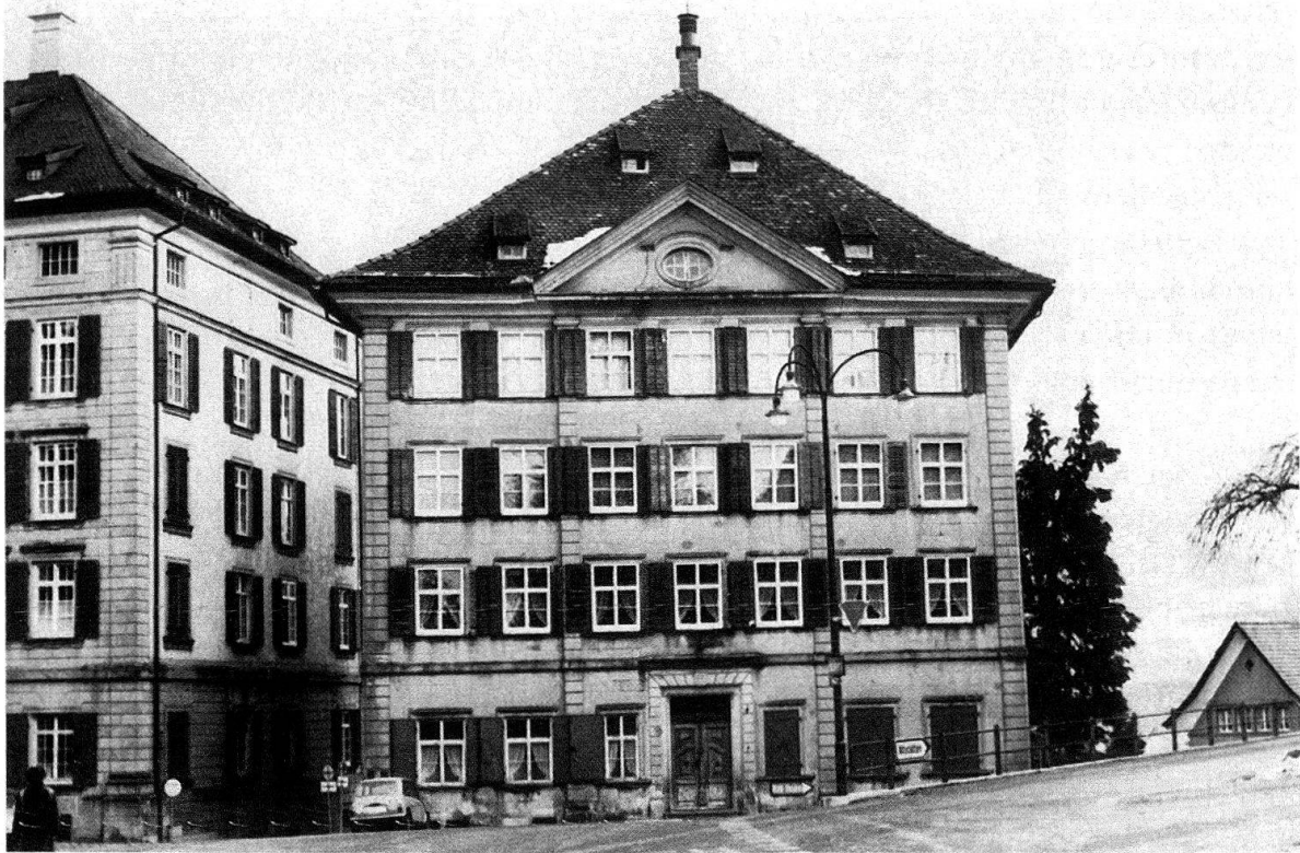
Trogen. Pfarr- und Gemeindehaus. Nordfassade
