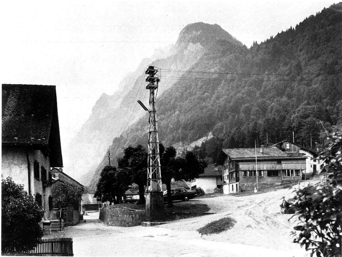
Näfels. Fahrtsplatz. Heutiger Zustand, der nach der alten Vorlage saniert werden soll; der hässliche Elektromast soll verschwinden
