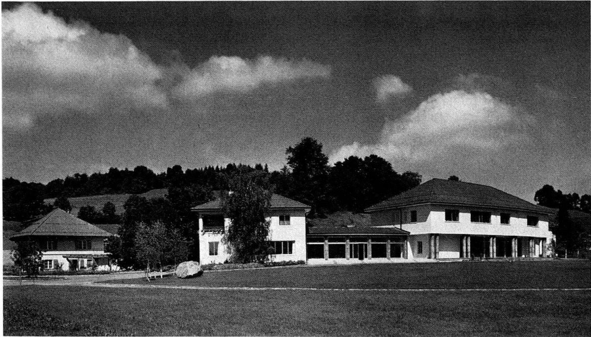
Abegg-Stiftung Bern in Riggisberg. Institutsgebäude
