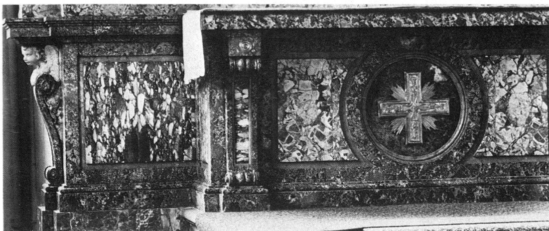
Abb. 4. St. Verena in Wollerau, Teil des Stipes des Hauptaltars. Man erkennt die Rahmungen aus der Sorte grau-weissfleckig (a). Die grossen Felder bestehen aus weiss-violetter Breccie (links) und Arzobreccien. Die schmalen Einfassungen sind gelb. Plastische Attribute aus weissem Carraramarmor
