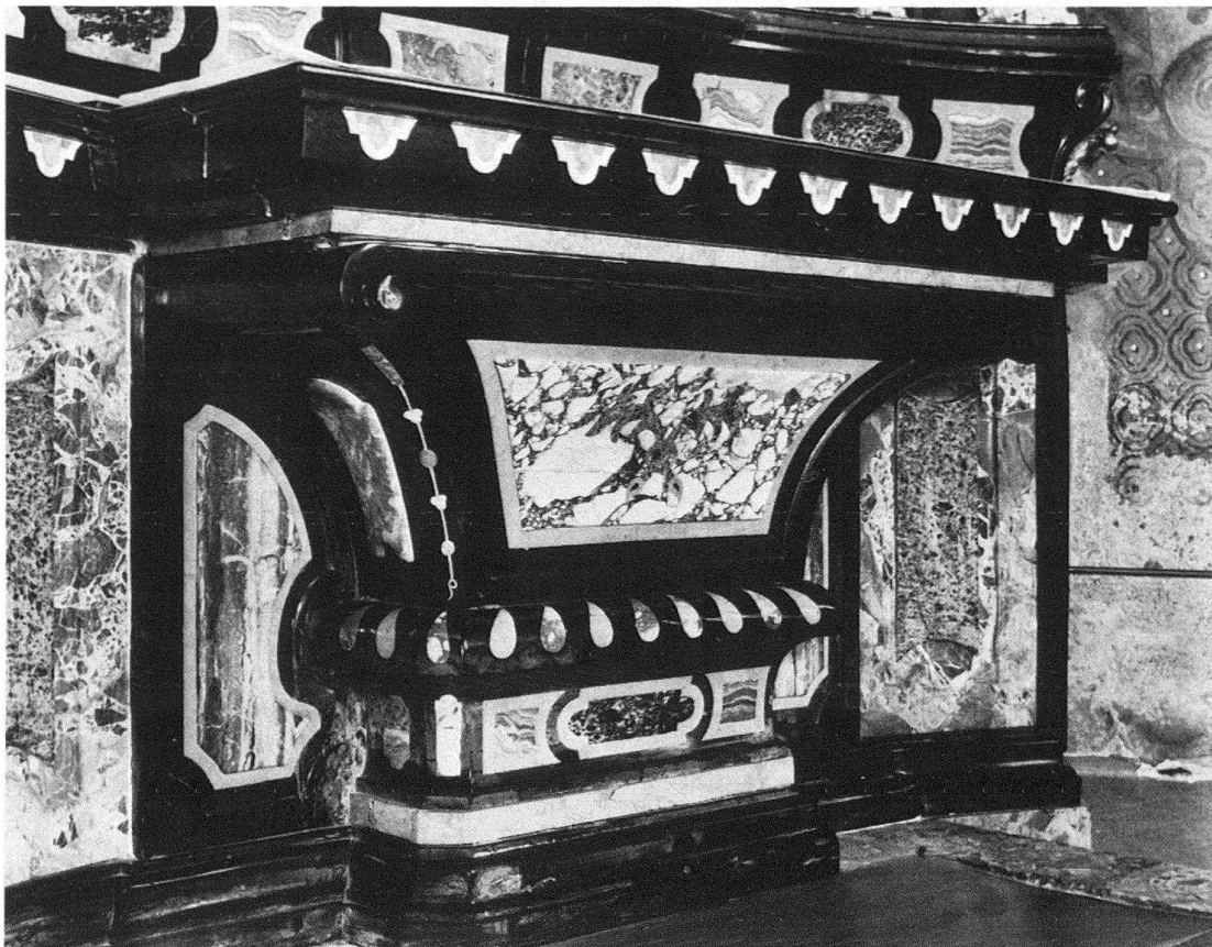
Abb. 2. Südlicher Seitenaltar in der Klosterkirche Fahr. Rahmen: schwarz, Frontale: weisse Breccie (e), Seitenteile: rote Arzobreccie mit grün-weissaderigen Auflagen. Intarsien: grün (f), bräunlichgebändert (i), rotstreifig (d, sehr deutlich links), kirschrot (c), rötlich-weisser Breccie (k). Die Einfassungen sind vorwiegend gelb (b), untergeordnet weiss
