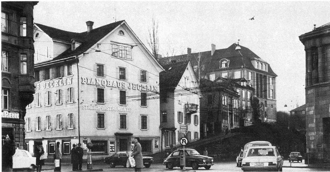
Abb. 2. Die alte «Stirnfront» des Zeltwegquartiers am Heimplatz in Zürich, entstanden um 1835; zuoberst die Töchterschule auf der Hohen Promenade (1912–1914). Photo 1974 von Hans Martin Gubler, Zürich.
