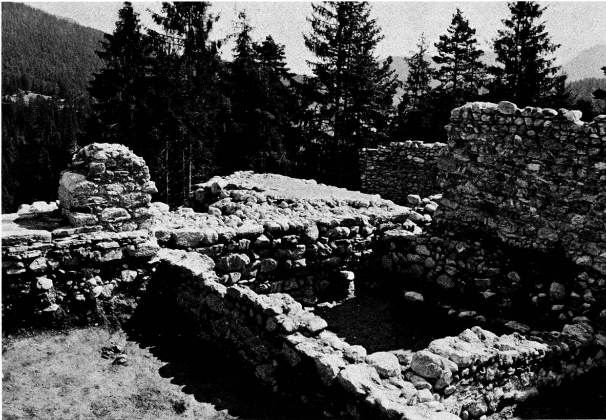
Abb. 2. Schiedberg bei Sagens. Ausgrabung 1968. Im Vordergrund frühmittelalterliches Mauerwerk (mutmassliches «Tellohaus»). Im Mittelgrund rechts wehrhafter Palas (2. Hälfte 13. Jahrhundert), links Turmfundament (12. Jahrhundert), darüber Mauerzahn des wehrhaften Palas. Im Hintergrund Ostbering (12./13. Jahrhundert). Blick gegen Nordosten
