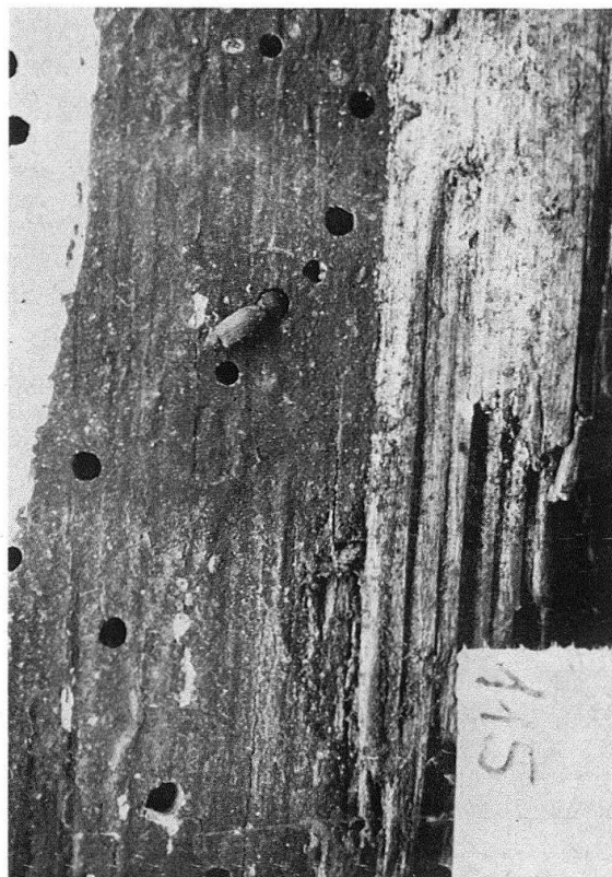
Abb. 6. Zillis, St. Martin. Holztafel mit Anobienbefall
