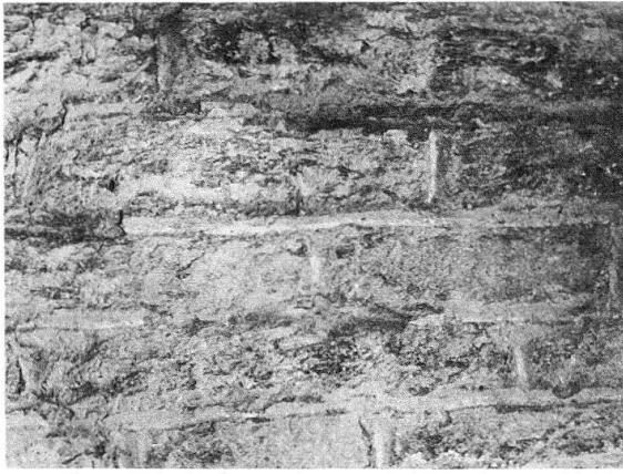
Abb. 3. Zillis, St. Martin. Nordwand, Mauerfugung mit Kellenstrich und weissen Pinselzügen nach der Freilegung
